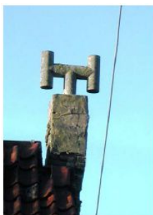
Deze buitendakse schouwen zijn onstabiel. Er dreigt ook instortingsgevaar zodat onmiddellijke actie (stutten, afbreuk) aanbevolen is, desnoods via toepassing van de Nieuwe Gemeentewet art. 135.
