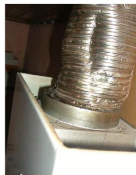
Deze verbindingen tussen aansluitkanaal, afvoerstop en/of afvoerkanaal zijn niet verdicht.
