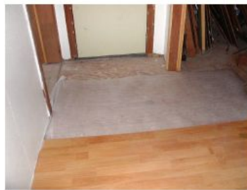
Ontbrekende stukken van de afwerkingslaag die een gevaar opleveren voor de bewoners.
