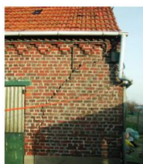
Stabiliteitsproblemen bij buitenmuren: Scheurvorming
