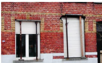
Dit is een tijdelijke oplossing om het onmiddellijke risico te beperken, maar kan niet als een definitieve herstelling worden beschouwd. Een specialist is verantwoord.
