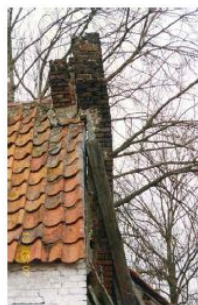
Deze buitendakse schouwen zijn onstabiel. Er dreigt ook instortingsgevaar zodat onmiddellijke actie (stutten, afbreuk) aanbevolen is, desnoods via toepassing van de Nieuwe Gemeentewet art. 135.
