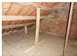
Dakstructuur: een ernstig aangetaste draagbalk
