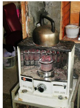
Mobiele verbrandingstoestellen die niet zijn aangesloten op een rookgasafvoer. Het al dan niet quoteren zal afhangen van de situatie in haar geheel. In ieder geval gebeurt er steeds een opname in de rubriek opmerkingen. Bovendien moet alles in het werk gesteld worden om de bewoners op de hoogte te brengen van de gevaren van dergelijke toestellen.
