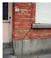
Stabiliteitsproblemen bij buitenmuren: Scheurvorming
