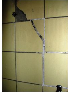
Voorbeelden van scheurvorming bij dragende binnenmuren
