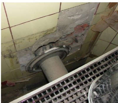
Deze verbindingen tussen aansluitkanaal, afvoerstop en/of afvoerkanaal zijn niet verdicht.
