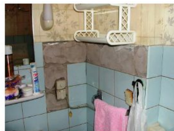
Binnenmuren: de noodzakelijke afwerking (betegeling) ontbreekt gedeeltesjk.
