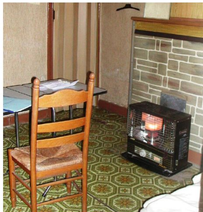
Mobiele verbrandingstoestellen die niet zijn aangesloten op een rookgasafvoer. Het al dan niet quoteren zal afhangen van de situatie in haar geheel. In ieder geval gebeurt er steeds een opname in de rubriek opmerkingen. Bovendien moet alles in het werk gesteld worden om de bewoners op de hoogte te brengen van de gevaren van dergelijke toestellen.
