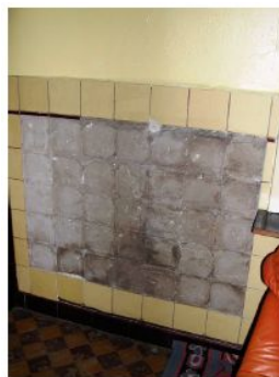
Binnenmuren: de noodzakelijke afwerking (betegeling) ontbreekt gedeeltesjk.
