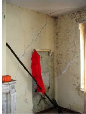
Voorbeelden van scheurvorming bij dragende binnenmuren
