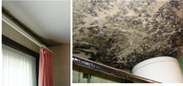
Plafonds: condenserend vocht. Links een typische koudebrug.
