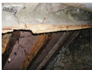
Dakstructuur: een ernstig aangetaste draagbalk
